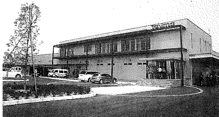
完成した新本社工場(館林市下早川田町)
